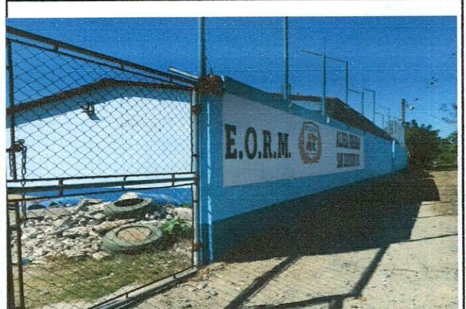
Foto 2: Mejoramiento de muro perimetral
