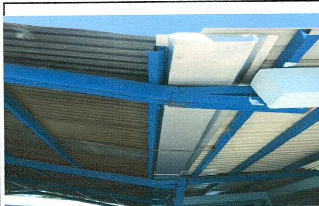
Foto 3: Instalacion de canales
